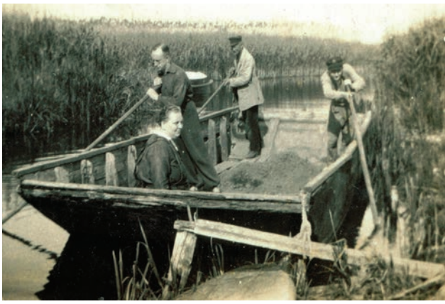
Die Bootseinfahrt wurde mit der Hand ausgeschachtet. Die Ruderer und Wassersportler hatten einen sturmsicheren Hafen. Fotos: Schöntges
